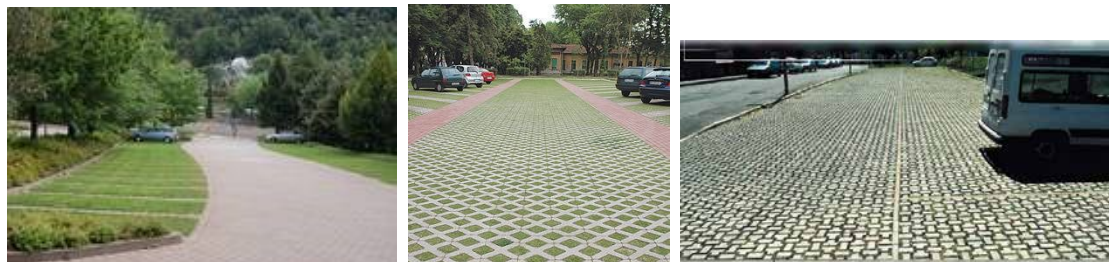
Figura 34 - Esempi di pavimentazioni permeabili
