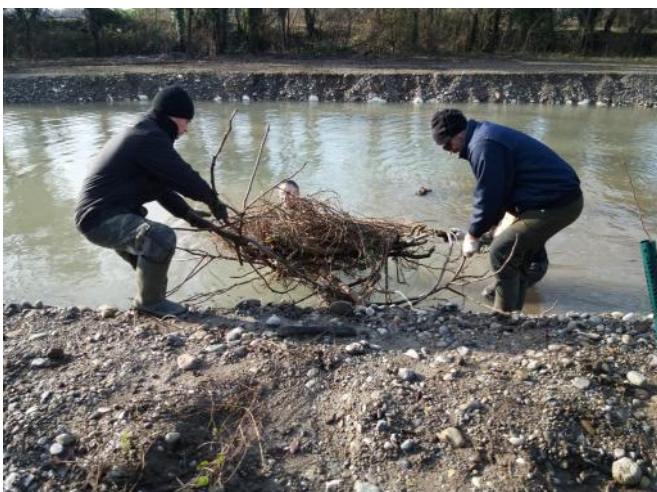
Predisposizione dei 'rifugi' nel nuovo laghetto
