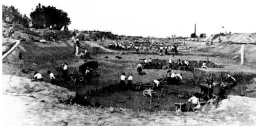
Badilanti e carriolanti durante la costruzione del canale Vacchelli
