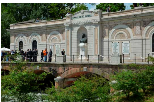
L'edificio di presa
