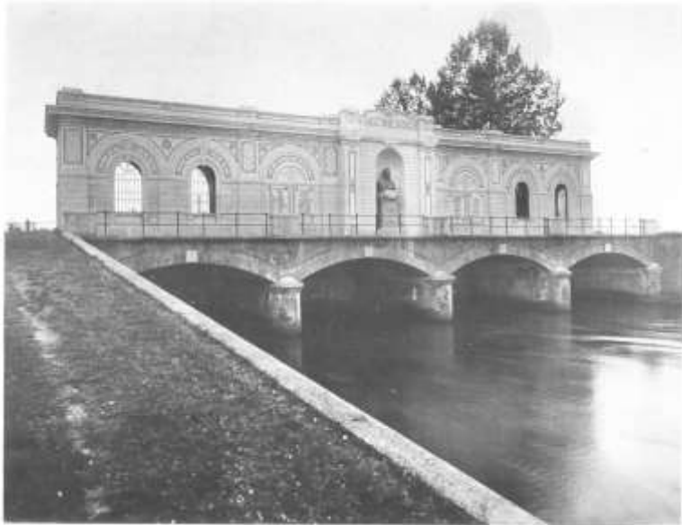
Canale 'Marzano': presa sul fiume Adda Opera di regolazione vista da valle
