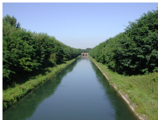
Il canale scorre in trincea
