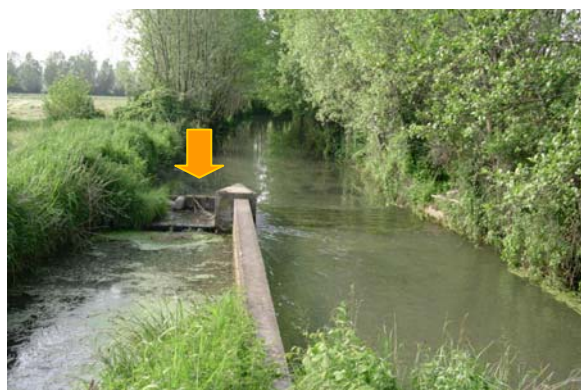
Fig.46 (alto) – Posizione dei due partitori oggetto di manovre su Nodello e Rino - (basso) Asta di legno posta a sbarramento presso il partitore sulla Roggia Nodello.
