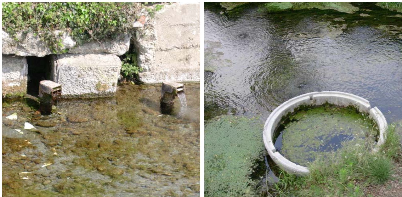
Fig.5 – Differenti bocche di fontanile: a sinistra fontanile dei Mosi nei pressi di Misano. A destra tino in cemento presso Dovera.
