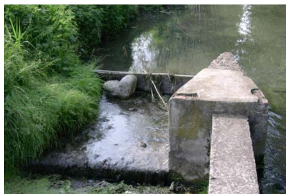
Fig.46 (alto) – Posizione dei due partitori oggetto di manovre su Nodello e Rino - (basso) Asta di legno posta a sbarramento presso il partitore sulla Roggia Nodello.
