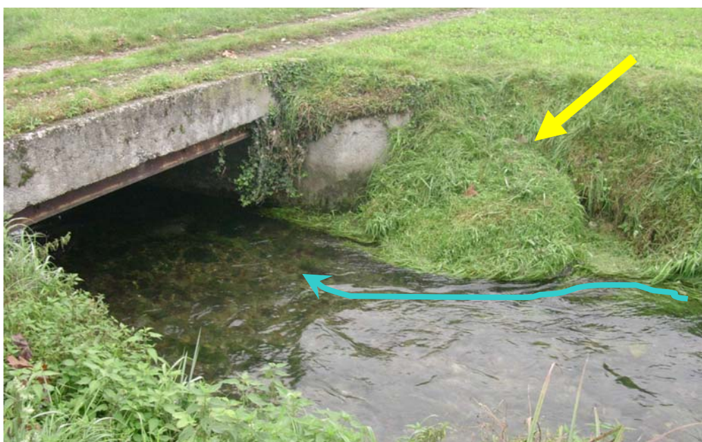
Fig. 61 – Accumulo di erba da sfalcio nei pressi della sezione M1 sul Tormo .
