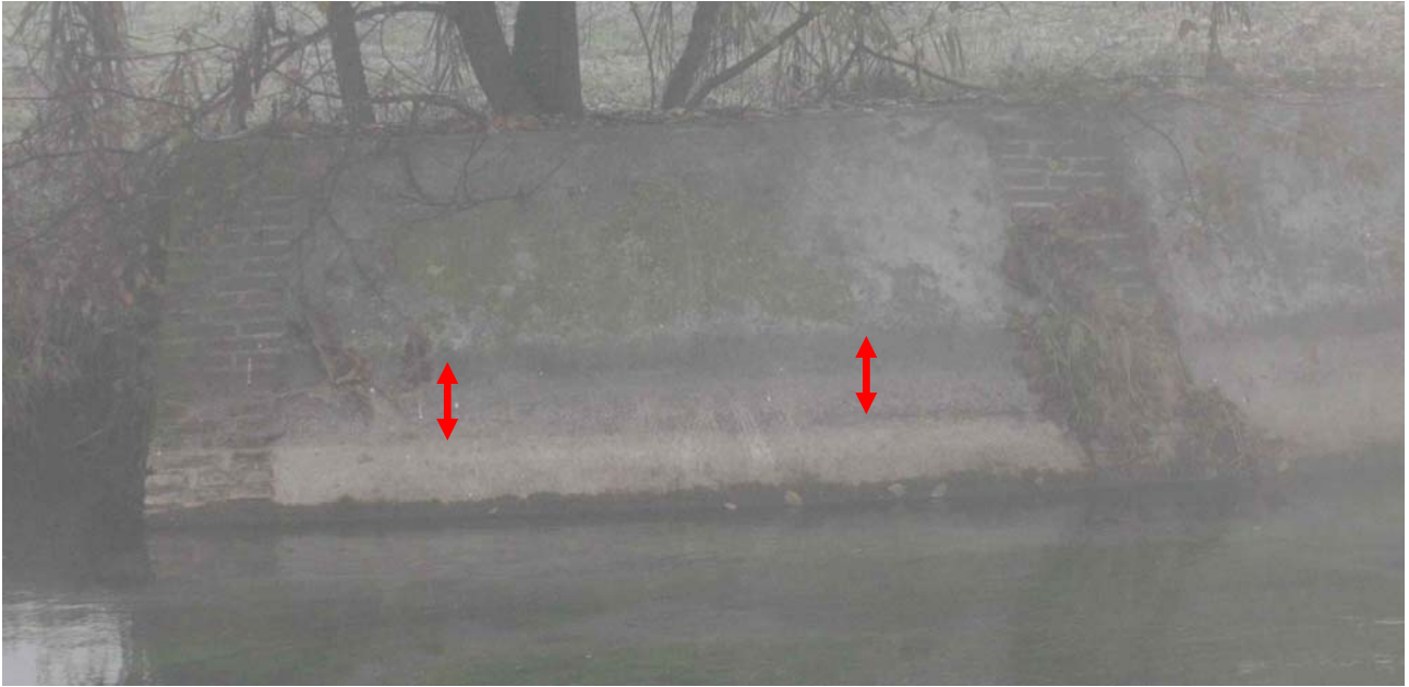
Fig.71 – Sezione 1 sul Tormo: è evidenziata la differenza di livello tra il 2005 e una stagione media.
