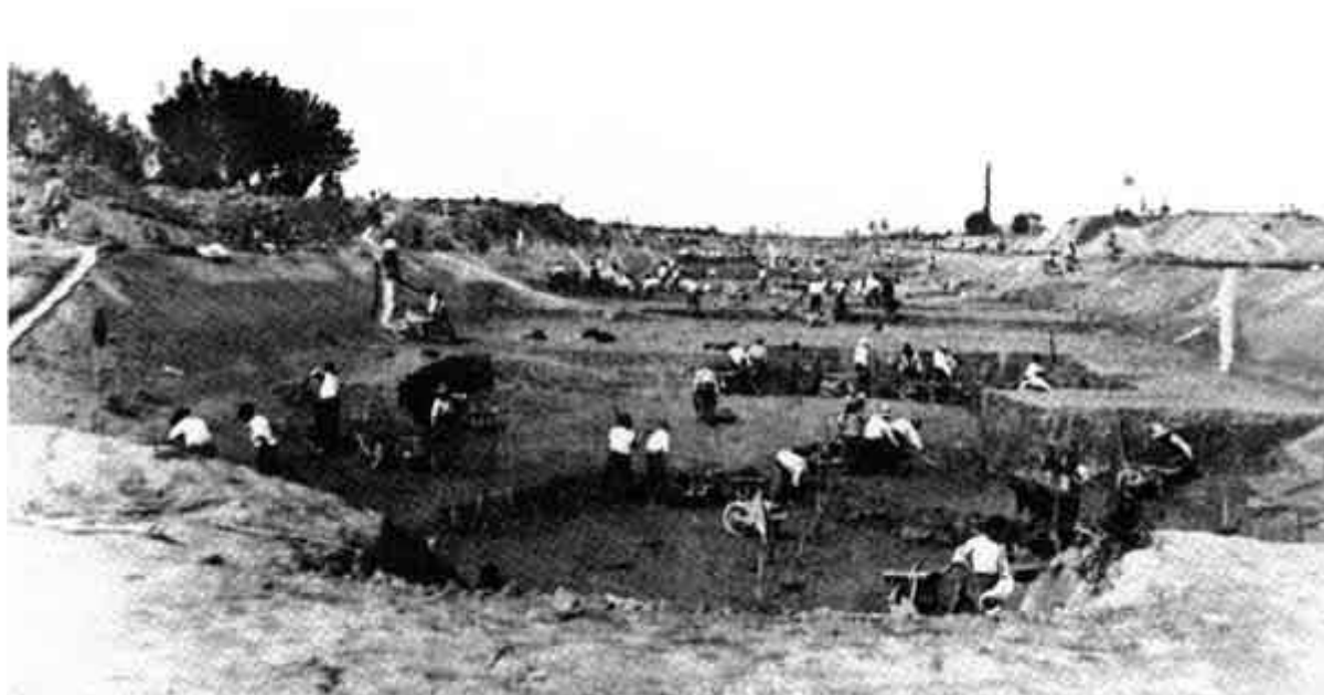
Fig.11 - Cariolanti e badilanti durante la costruzione del Canale Pietro Vacchelli nel 1888
