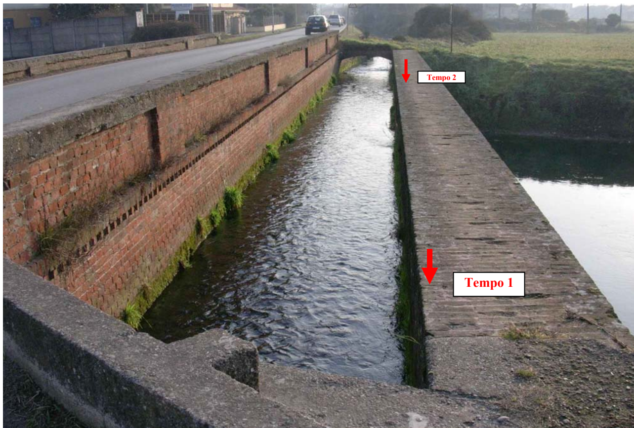
Fig. 80– Sezione 5 sul Merlò. Sono indicati i capisaldi di misura dei tempi di passaggio del galleggiante
