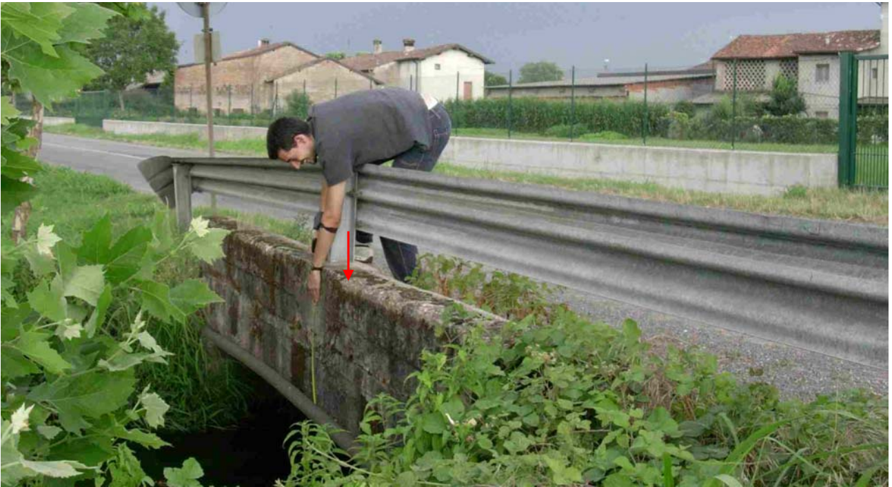
Fig.31 – Punto di misurazione ST2B Roggia Quarantina
