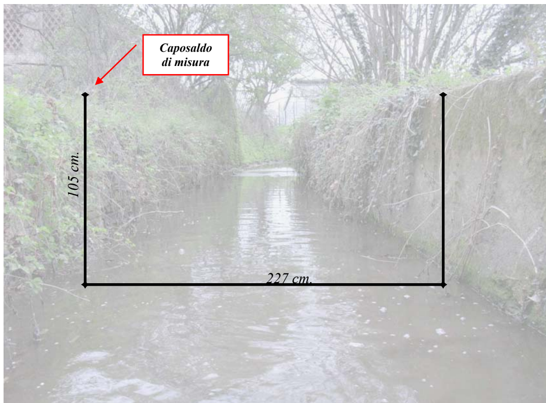
Fig. 64 – Geometria della sezione ST5 sulla roggia Landriana. Pontecanale sulla roggia Merlò Giovane nei pressi della Cascina Carezza (Rivolta d'Adda)
