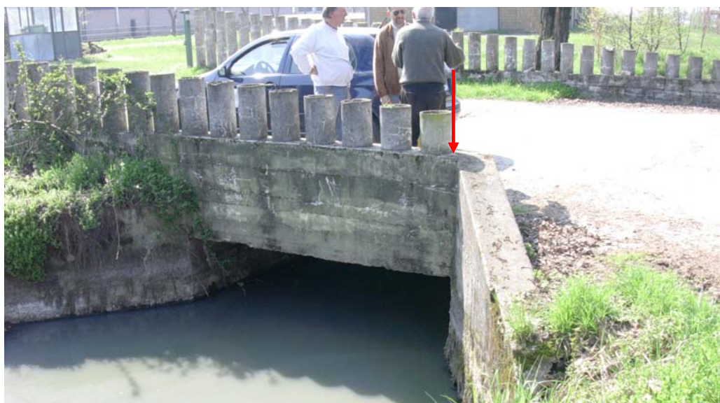
Fig. 36 – Punto di misurazione ST4 Tormello
