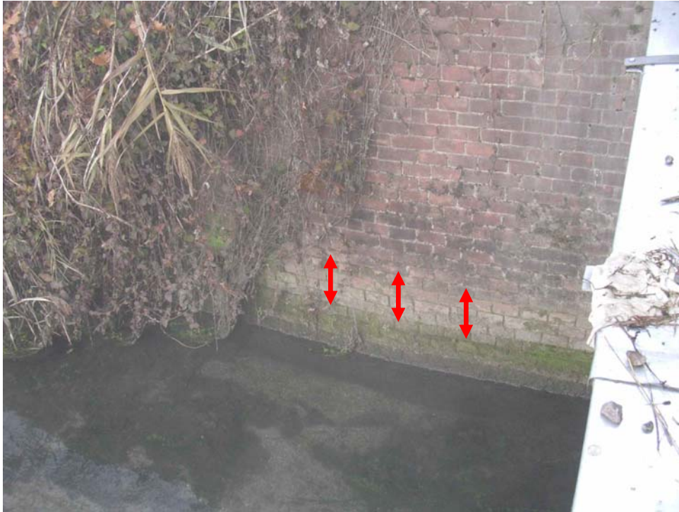
Fig.73 – Sezione 3 sul Tormo: è evidenziata la differenza di livello tra il 2005 e una stagione media.
