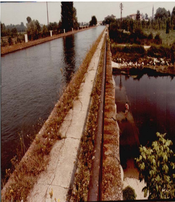
Fig. 7 - Il Vacchelli passa al di sopra del fiume Serio
