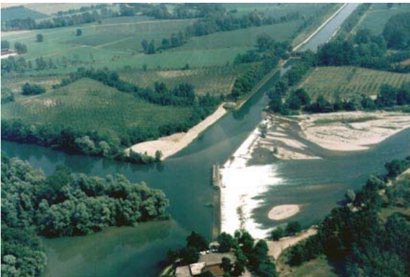
Fig. 5 - Presa del canale Vacchelli dal fiume Adda
