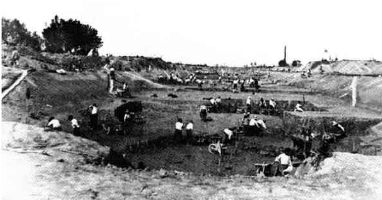
Fig. 2 - Il canale Vacchelli in costruzione
