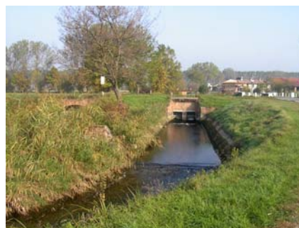
Fig. 32 – Presa della Geronda vista da valle
