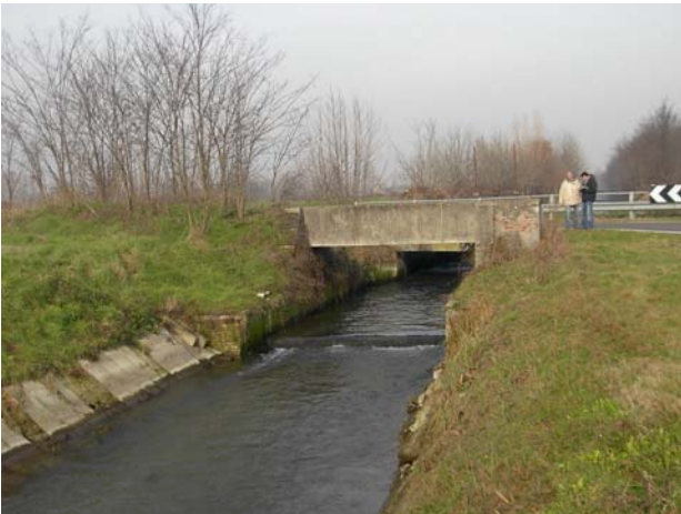
Fig. 41 – Presa del Nuovo Delmona vista da valle
