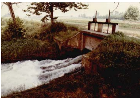
Fig. 31 - Presa del cavo Geronda
