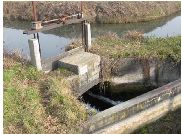
Fig. 42 - Presa Nuovo Delmona : manufatto di presa
