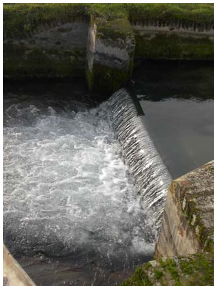
Fig. 27 - Stramazzo alla presa della Canobbia Nuova
