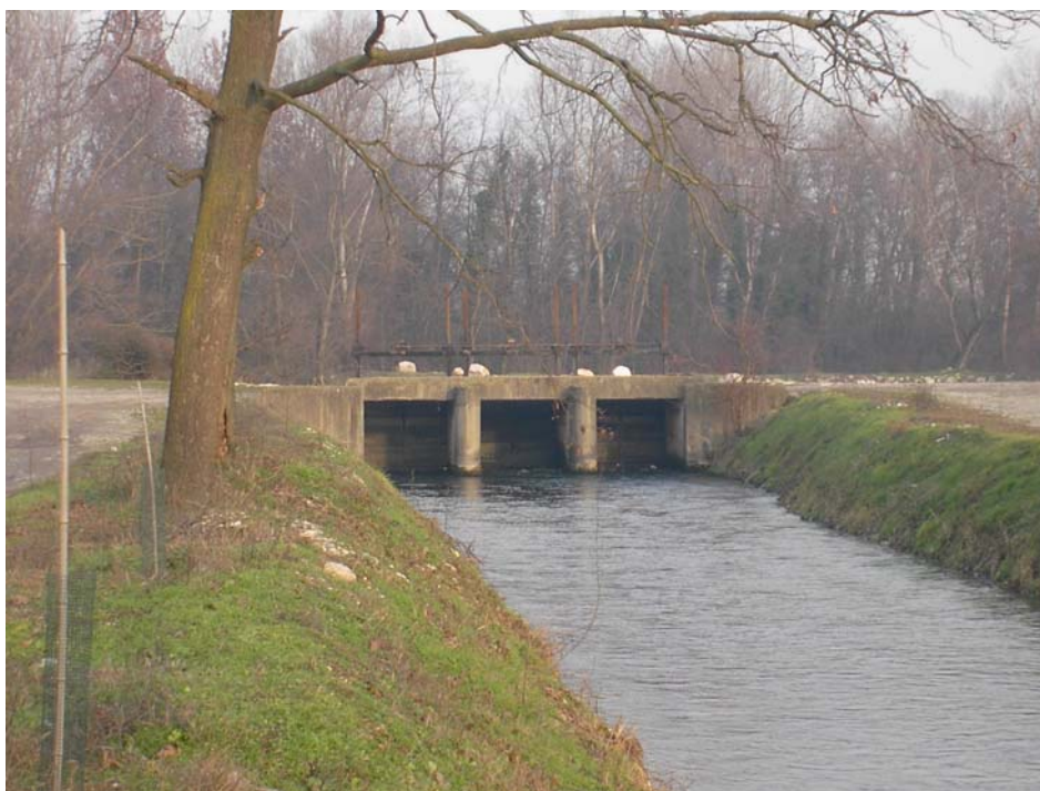
Fig. 34 - Presa del cavo Suppeditazione dal fiume Oglio
