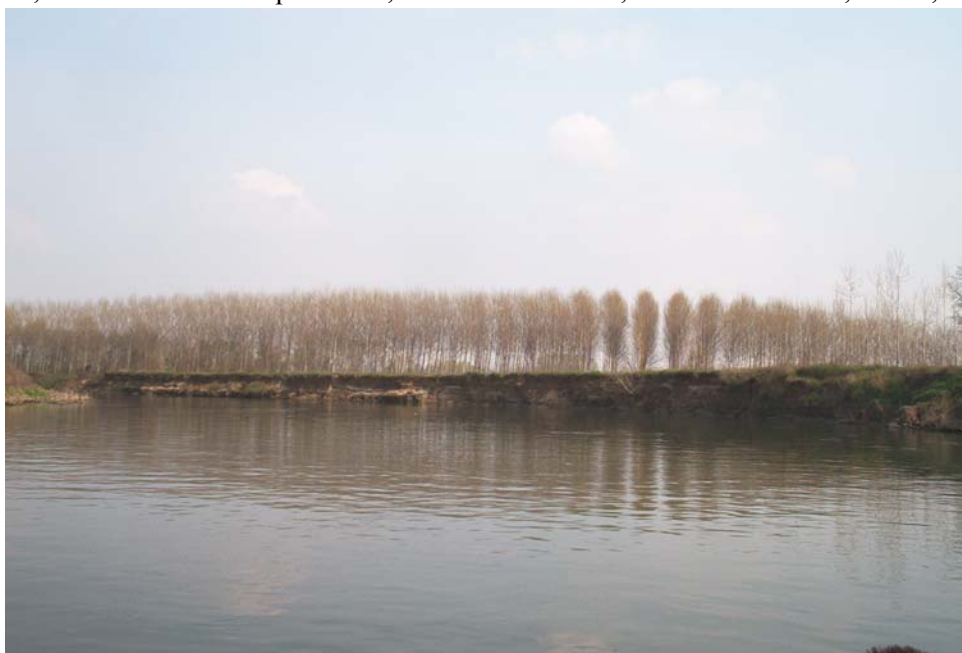
Fig.6 Erosione spondale lungo il fiume Oglio
