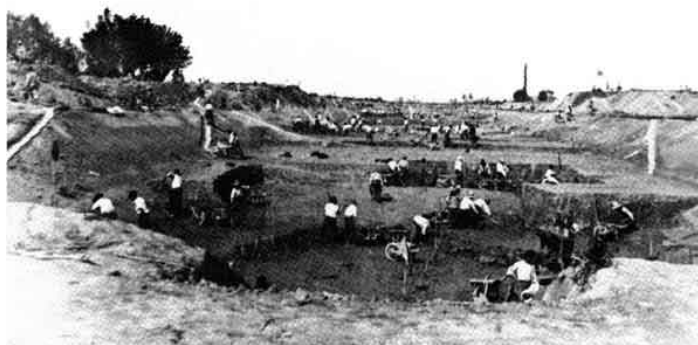
Fig. 10. Cariolanti e badilanti durante la costruzione del Canale Vacchelli 1888
