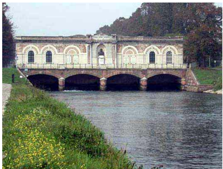
Fig. 11. La presa del Canale Vacchelli
