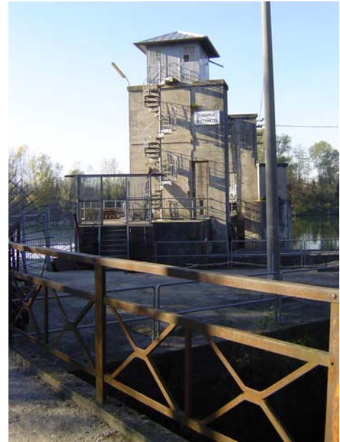
Fig. 30. La Torre contenente i meccanismi di controllo della Diga del Retorto alla Presa dell'Adda
